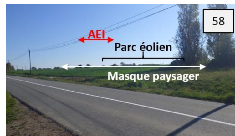
Vue depuis la RD3 en direction du nord-est : absence de visibilité
